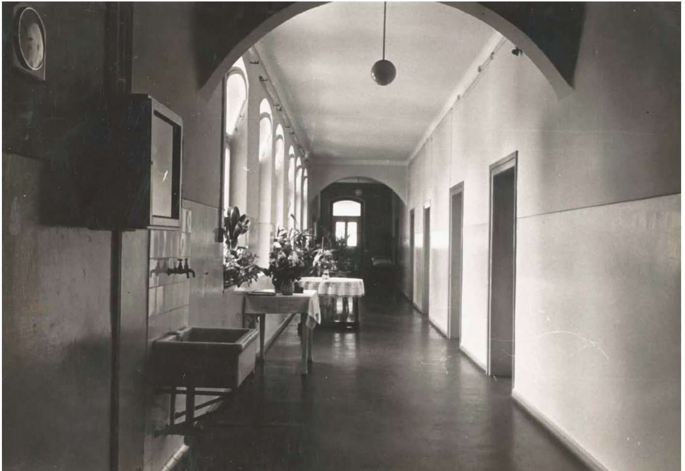
Abb. 4: Blick in einen Flur im alten Bezirkskrankenhaus am Galgenbühl im Jahr 1914.
