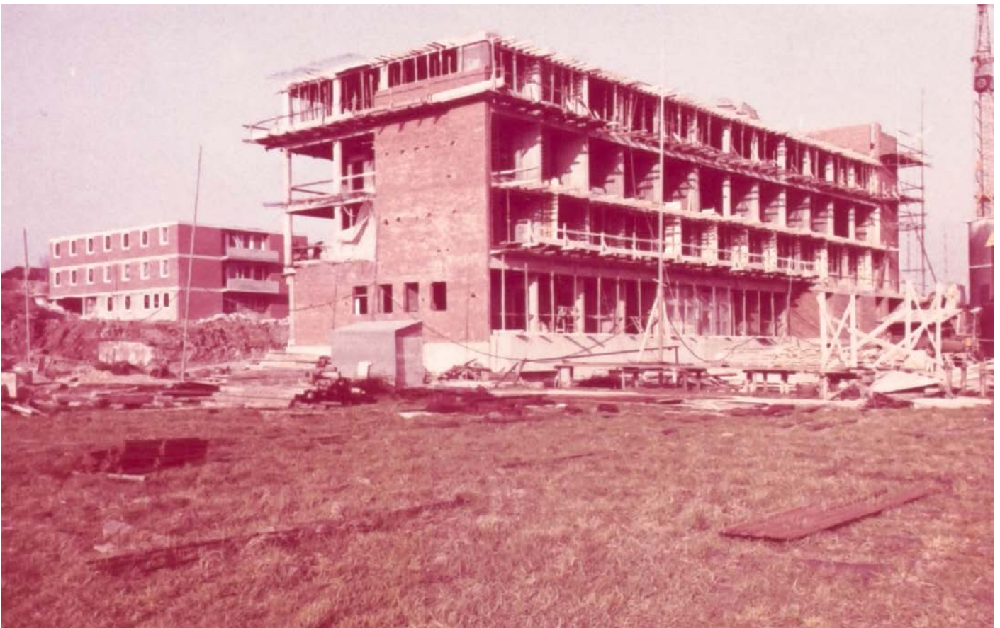
Abb. 5: Das neue Laufer Kreiskrankenhaus im Rohbau. Aufsetzen des letzten Stockwerks im März 1961.
